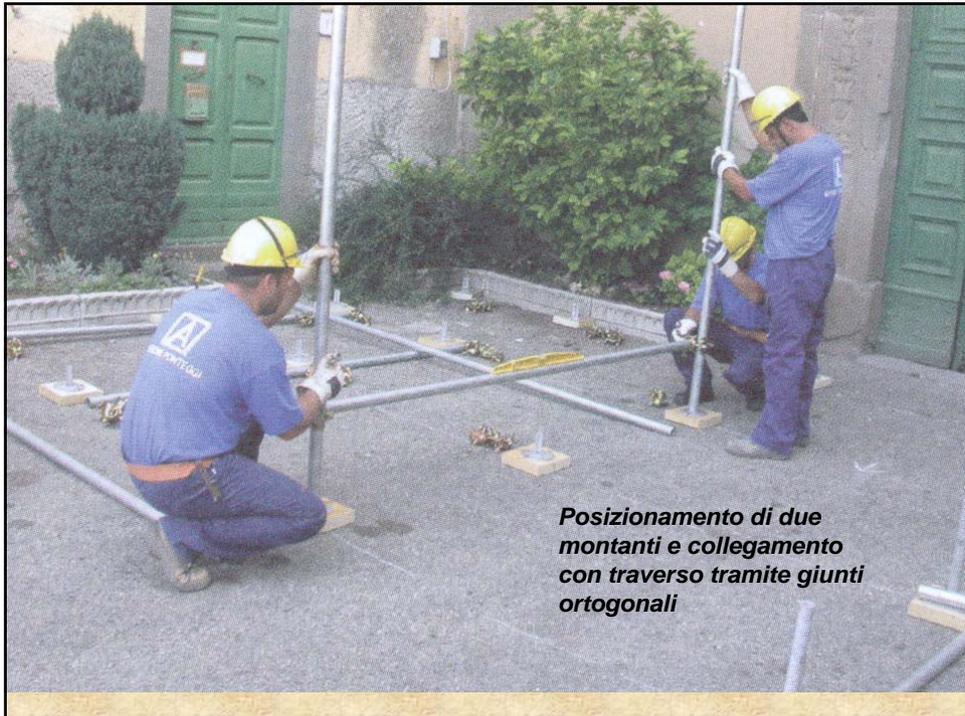
*Posizionamento di due montanti e collegamento con traverso tramite giunti ortogonali*
