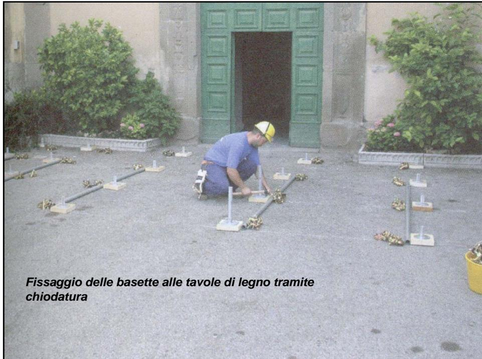
*Fissaggio delle basette alle tavole di legno tramite chiodatura*
